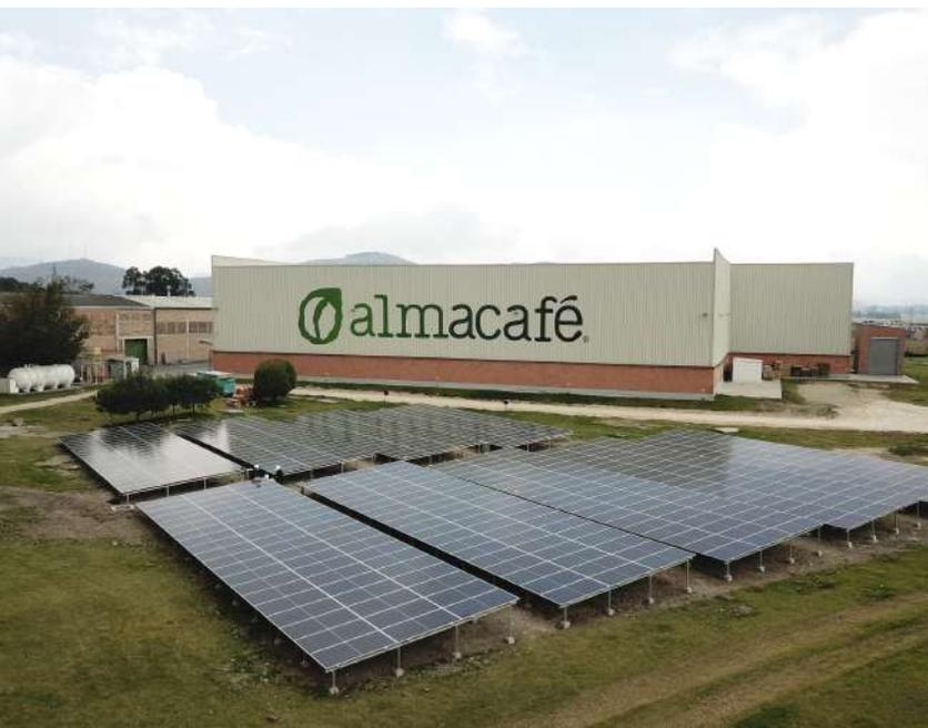
Instalar un sistema fotovoltaico de **216 kWp** que consta de **540 paneles** solares y **9 Inversores**, en nuestro centro logístico de Bogotá, que nos permitieron desde su operación en el mes de Octubre generar **60,11 MW** en autoconsumo, lo que equivale al 23% del consumo total del complejo industrial, evitando que **9,88 Ton de CO2** fueran emitidas.
